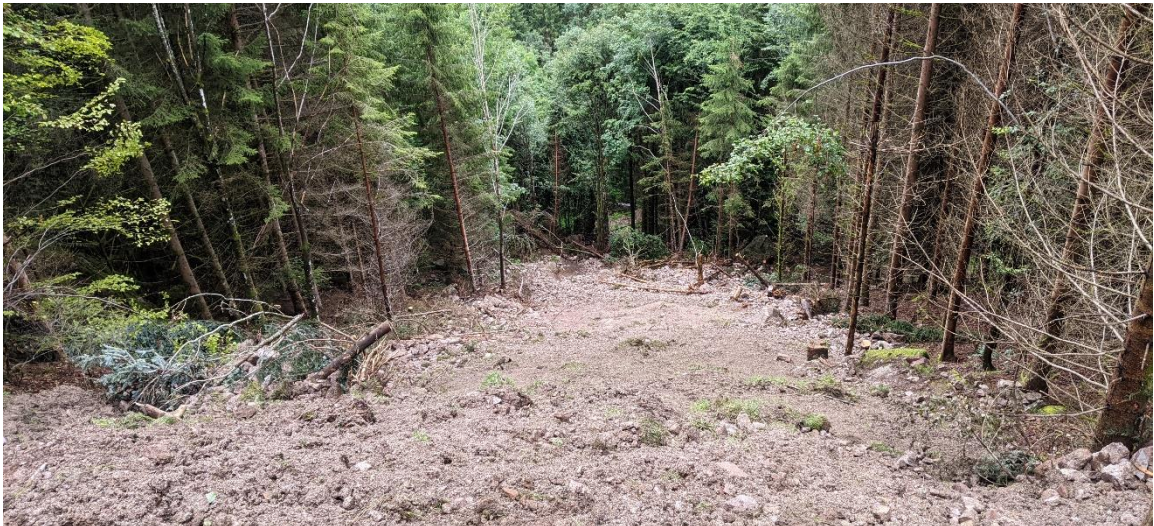
Abbildung 1: Hangrutschung mit Wegeabbruch nach einem Starkregenereignis
